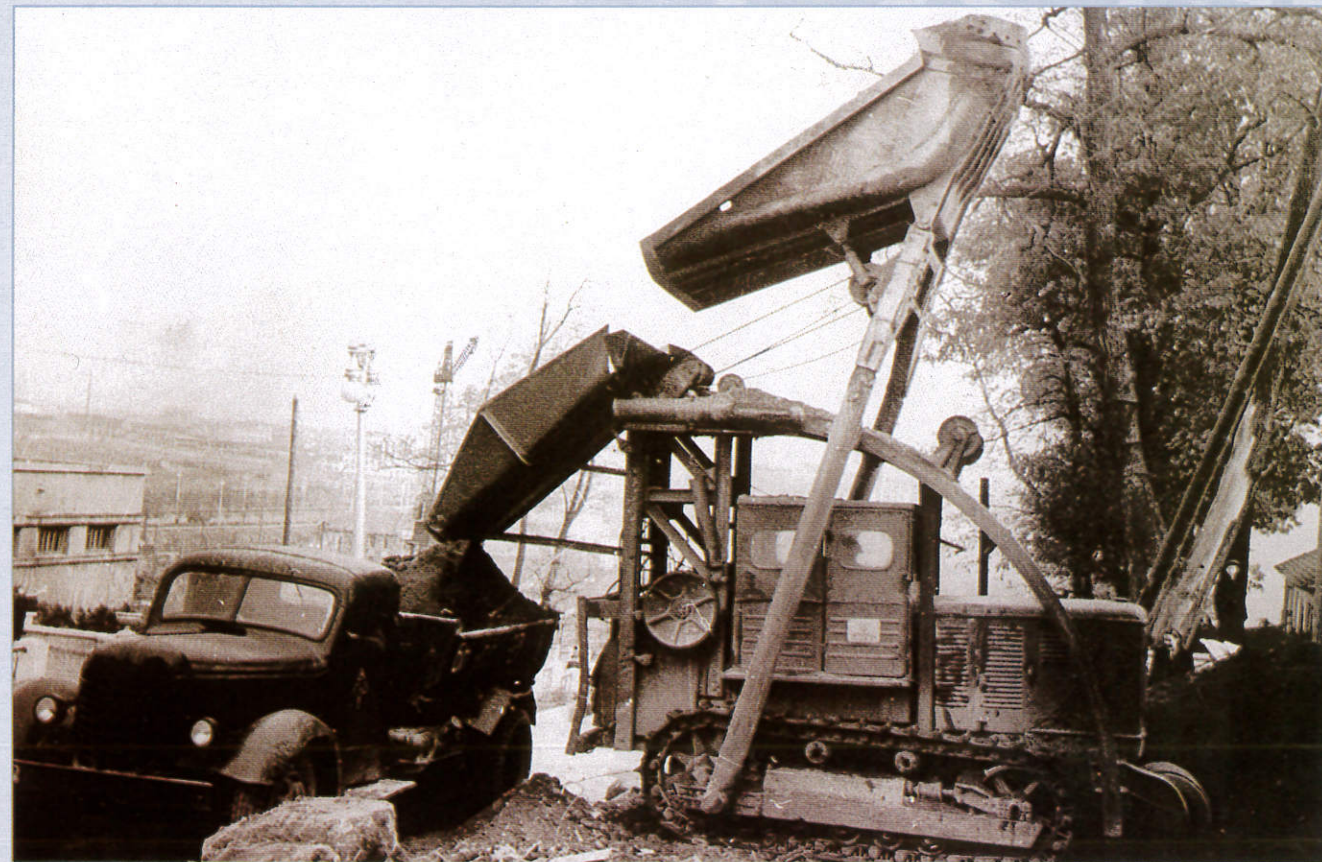
Погрузка грунта мехустановкой Т-107 (1952 г.).
