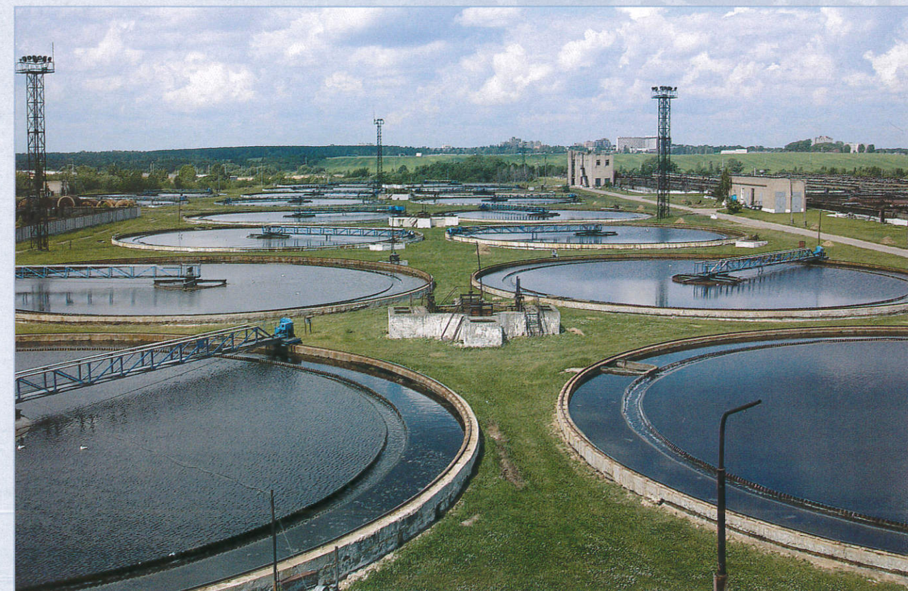
Радиальные отстойники станции аэрации.
