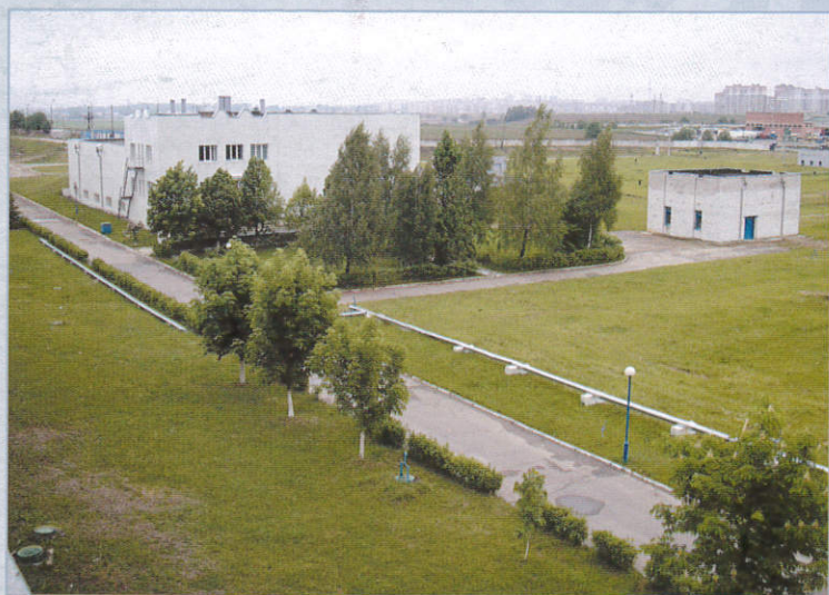
Озонаторная станция БОС-ВМВС.
