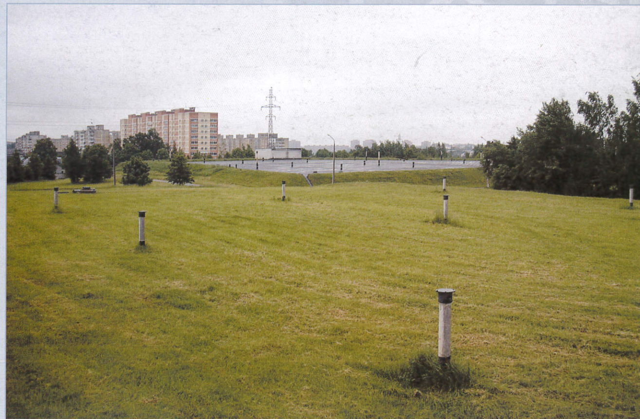
Водозабор «Дражня» – резервуары.
