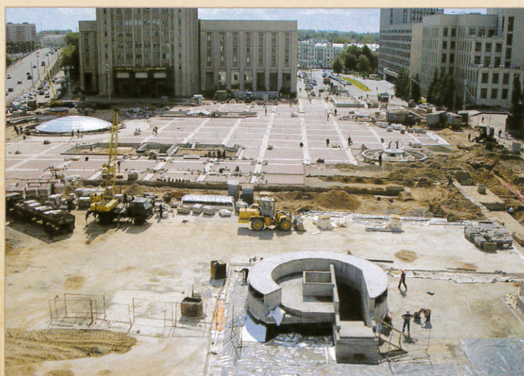
Комплексная реконструкция площади Независимости. Вторая очередь строительства.
