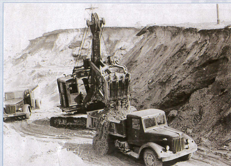
Работа в карьере экскаватора ОМ-205.
