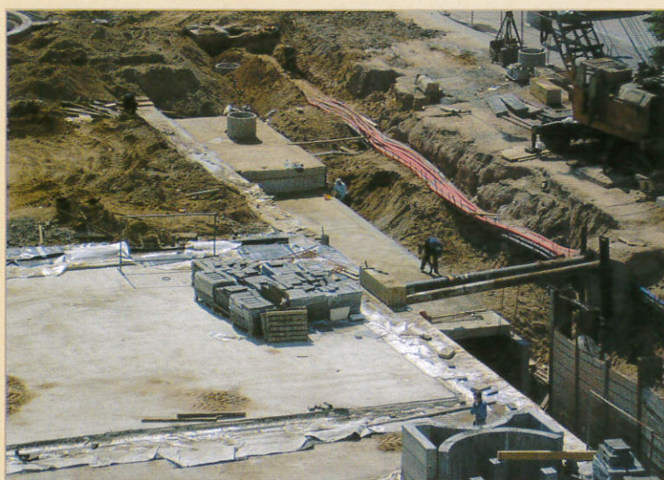
Коммуникационный коллектор на пл. Независимости.
