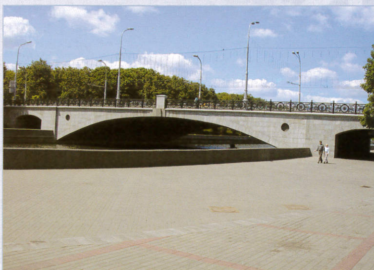
Мост через р. Свислочь.
