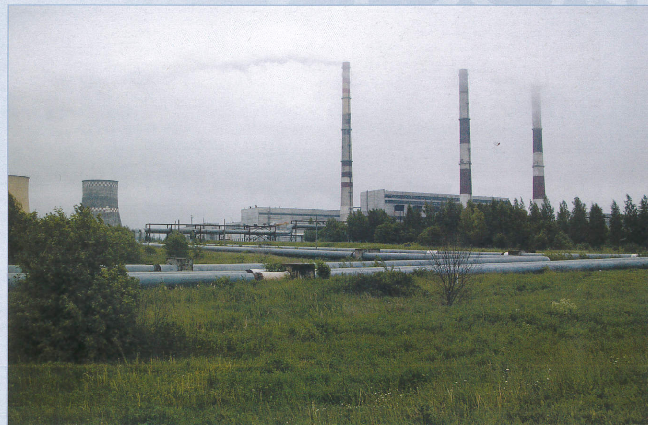
Теплосети от ТЭЦ-4.
