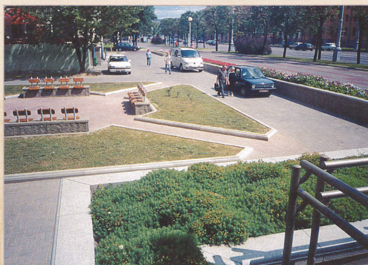
Капитальный ремонт пр. Скорины.
