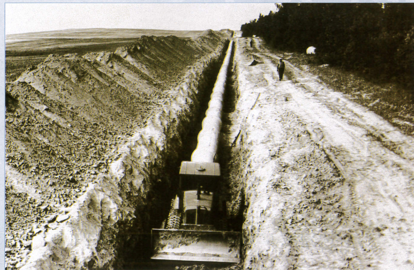
Укладка железобетонных труб.
