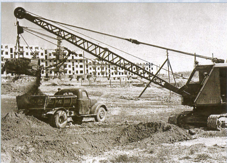
Погрузка грунта экскаватором З-652.
