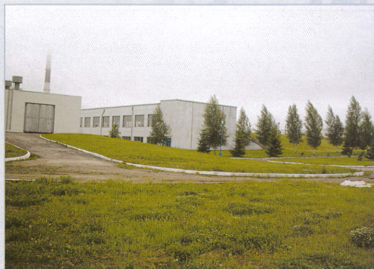
Блок фильтров БОС ВМВС.
