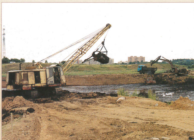
Выемка грунта, пруд-накопитель в микрорайоне «Лошица».
